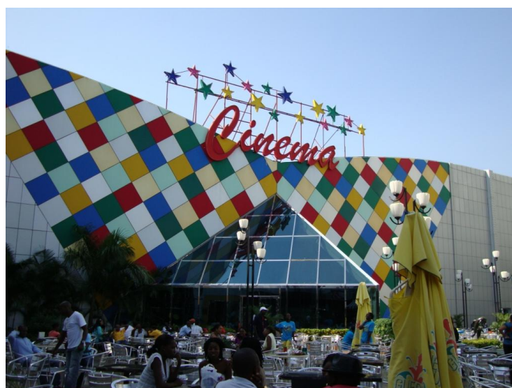
Cinema em obras, Shopping Maputo
